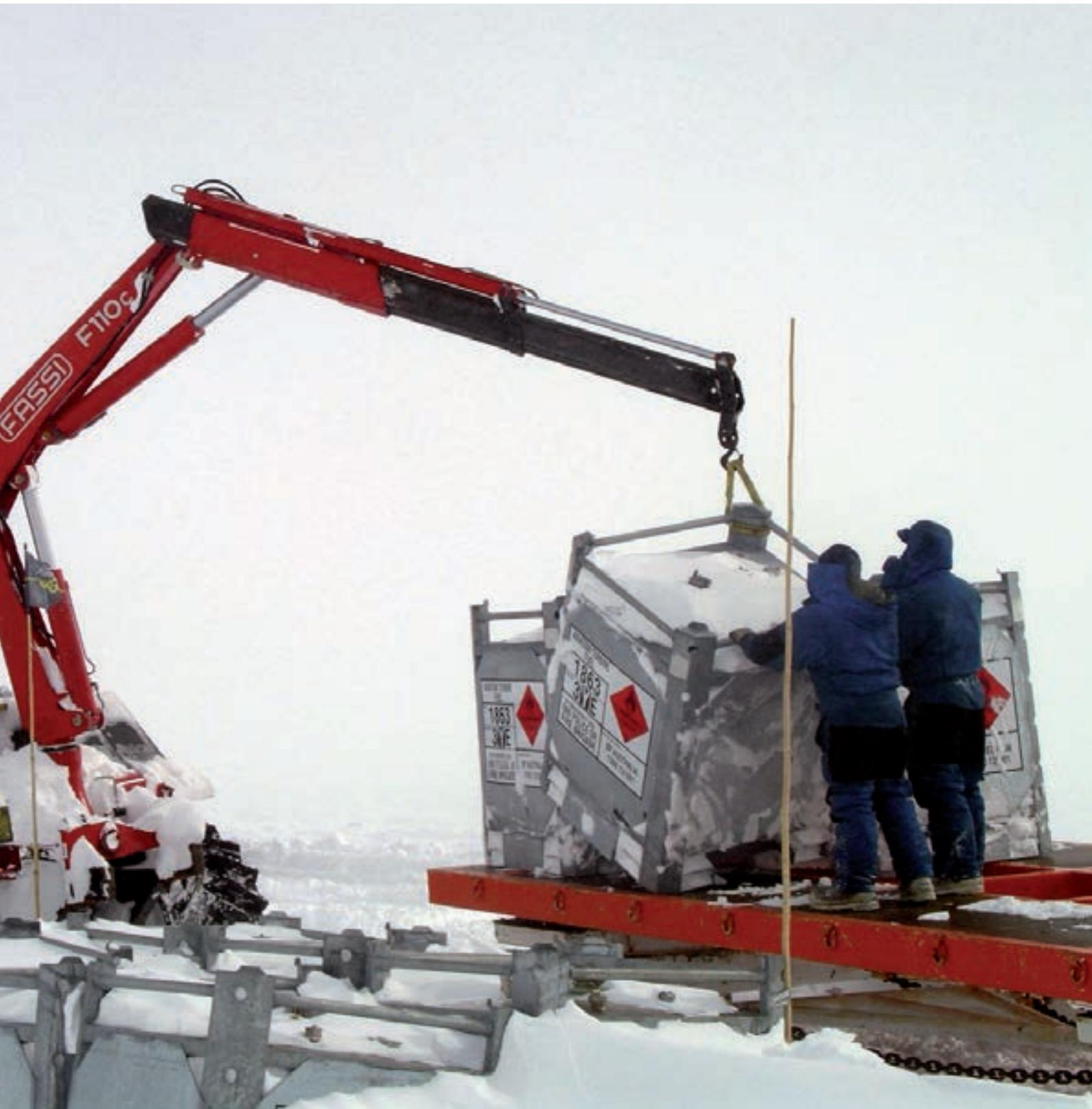
lors des opérations de chargement et de déchargement (625 tonnes de marchandises manutentionnées), nécessaires à la construction de la base Kunlun Station, en plus d'autres opérations spéciales, comme la récupération d'autres véhicules et, utilisées par deux, pour le levage de structures de grandes dimensions, comme les conteneurs.
