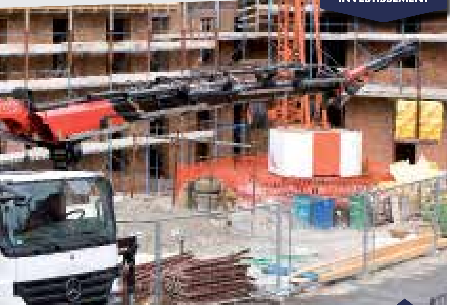
La gru F660RA in azione. Appartiene alla gamma pesante e solleva fino a 62tm di peso
