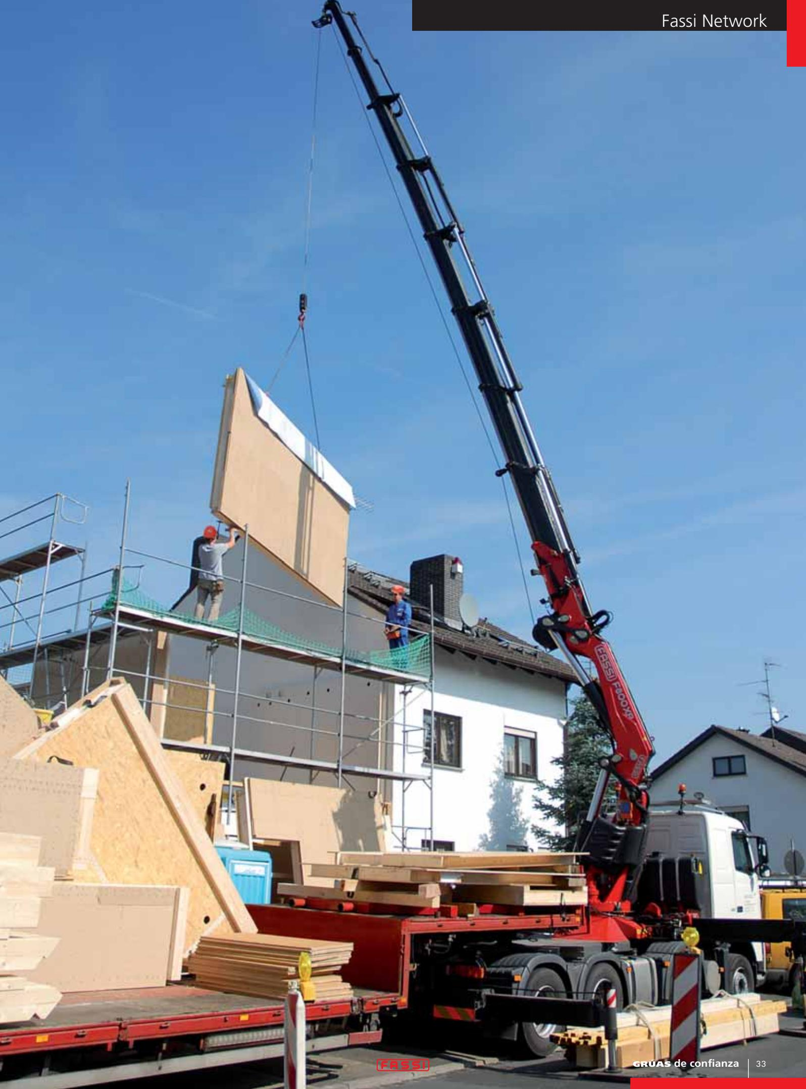
(carga 2.505 kg) y un brazo añadido (jib), para una extensión total de hasta 32,20 m (carga 270 kilos).
