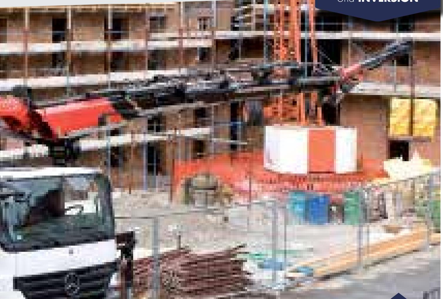
La grúa F660RA en funcionamiento. Pertenecer a la gama pesada y eleva hasta 62 t de peso
