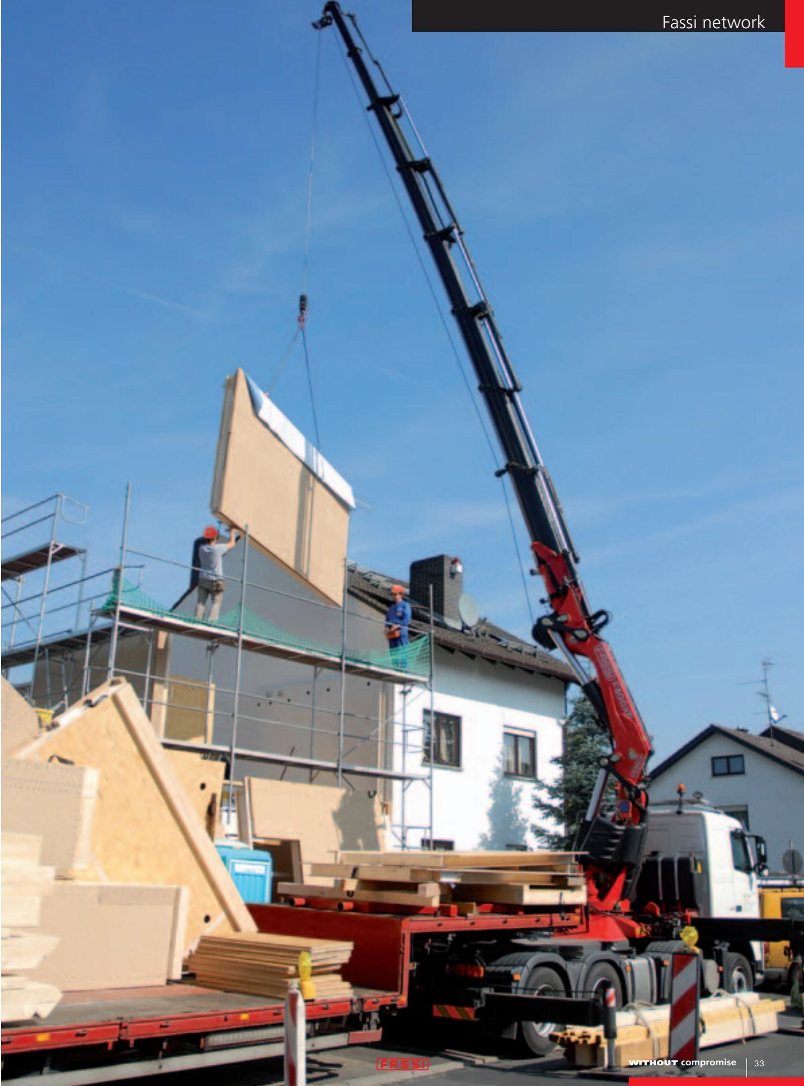
peso di 8450 kg ha uno sbraccio idraulico di 20,45 m (portata 2505 kg) ed è dotata di un braccio aggiuntivo (jib) per uno sbraccio totale fino a 32,20 m (portata 270 kg).
